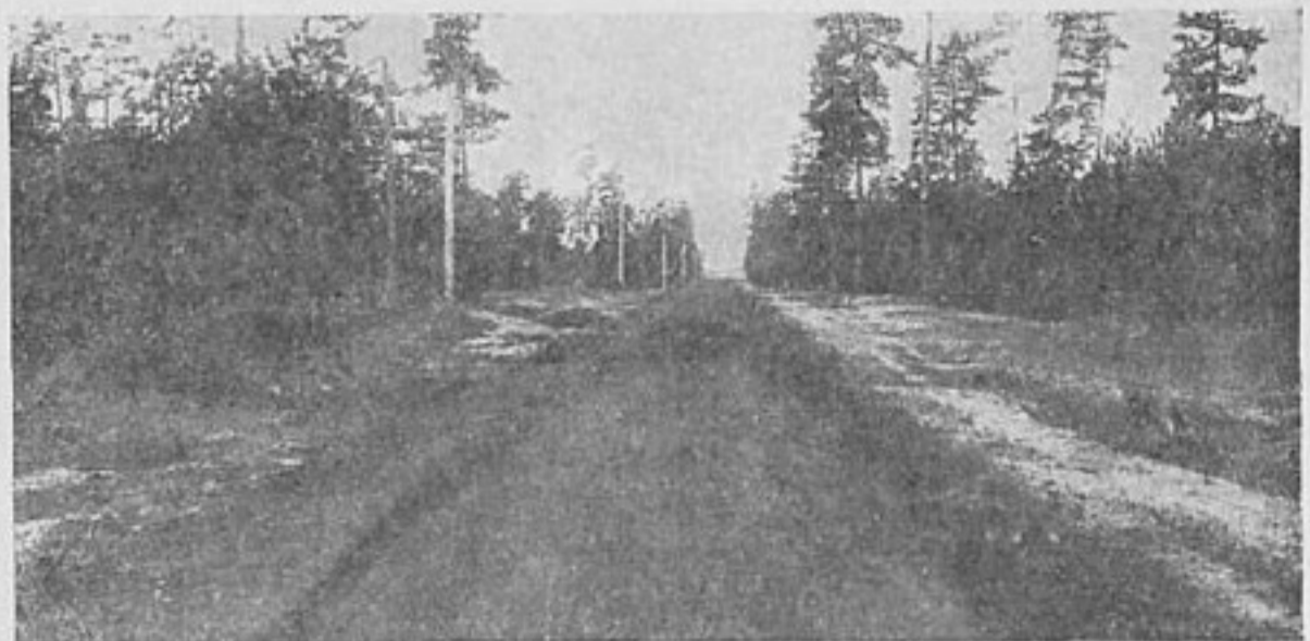
Дорога в песчаном грунте, укрепленная шлаком
