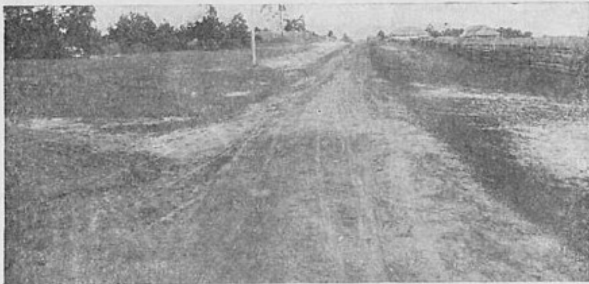
Дорога, укрепленная болотной рудой, на песчаном грунте
