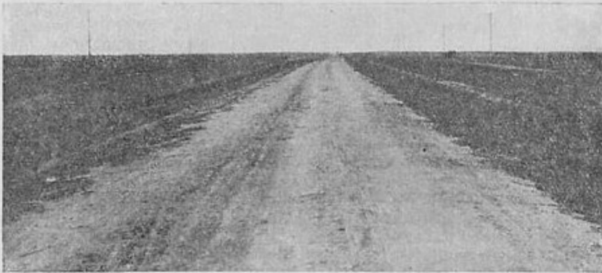
Дорога, укрепленная жерствой на суглинистом грунте
