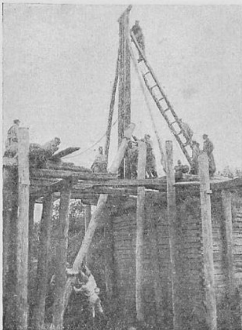
Саперы начали постройку моста через овраг (с. Коробочкино)
