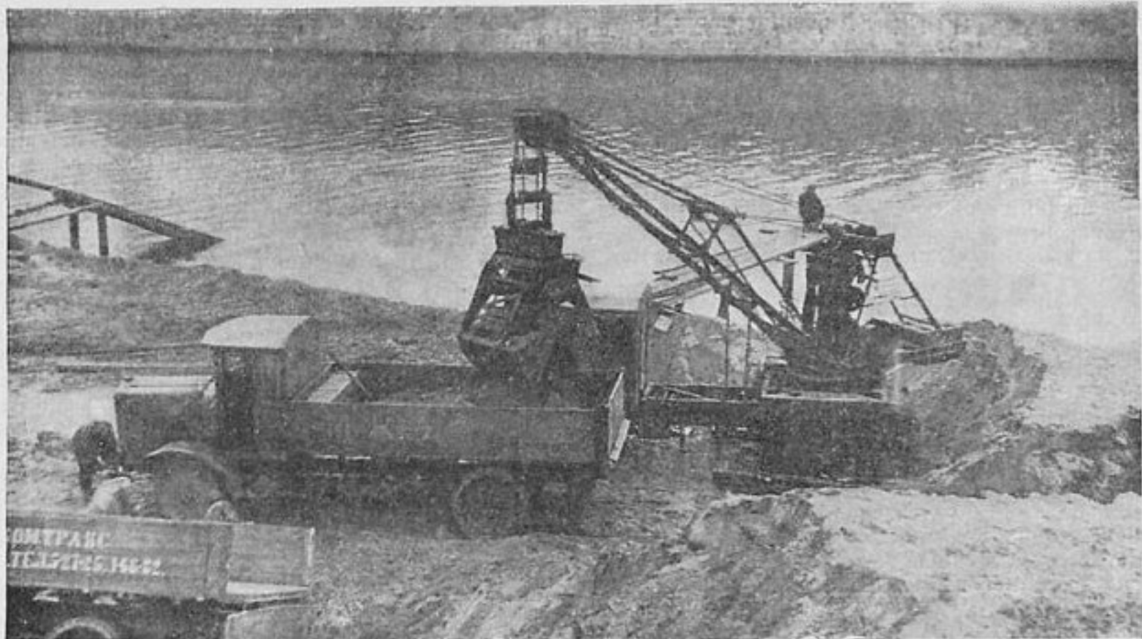
Земляные работы на Москве-реке
