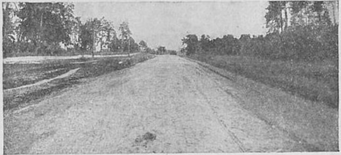
Дорога в песчаном грунте с добавкой глины
